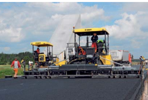
Укладка базового и слоя износа на скоростной автомобильной магистрали.
