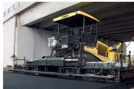
Укладка слоя на автомагистрали шириной 10 м.
