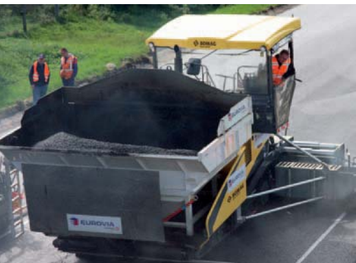
Асфальтоукладчик с дополнительным бункером при укладке верхнего слоя асфальтобетонного покрытия на скоростной автомобильной магистрали в Германии.
