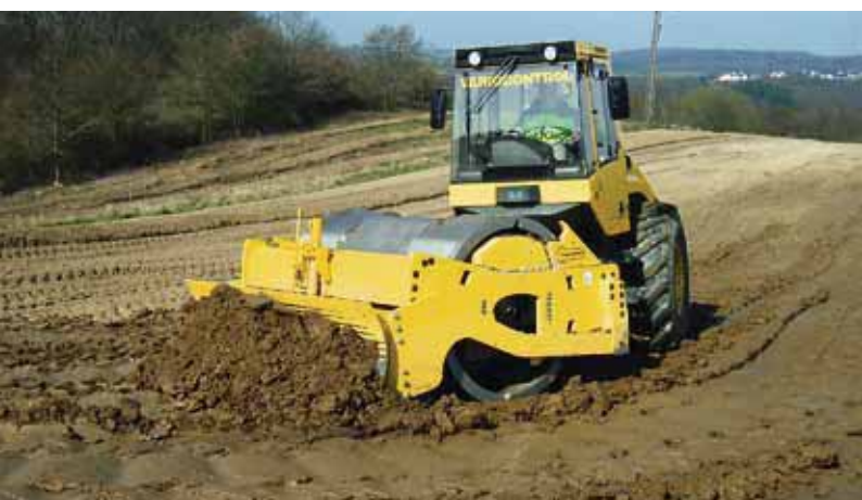
Одновременное распределение и уплотнение: грунтовый каток с отвалом на BW 213 DI.
